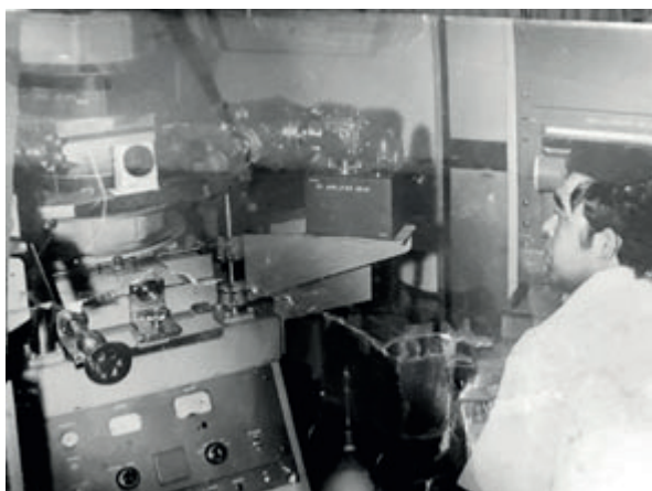
Fig. 2. Dr. Arístides Rosado Pérez (1973) trabajando con el espectrómetro de masas marca Hitachi Perkin-Elmer modelo RMU-6D en el Departamento de Espectroscopía Molecular en el CENIC. (Fotografía cortesía del Dr. Rosado).
