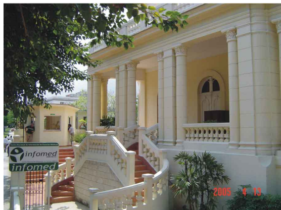
Fig. 1. Oficinas centrales de Infomed
