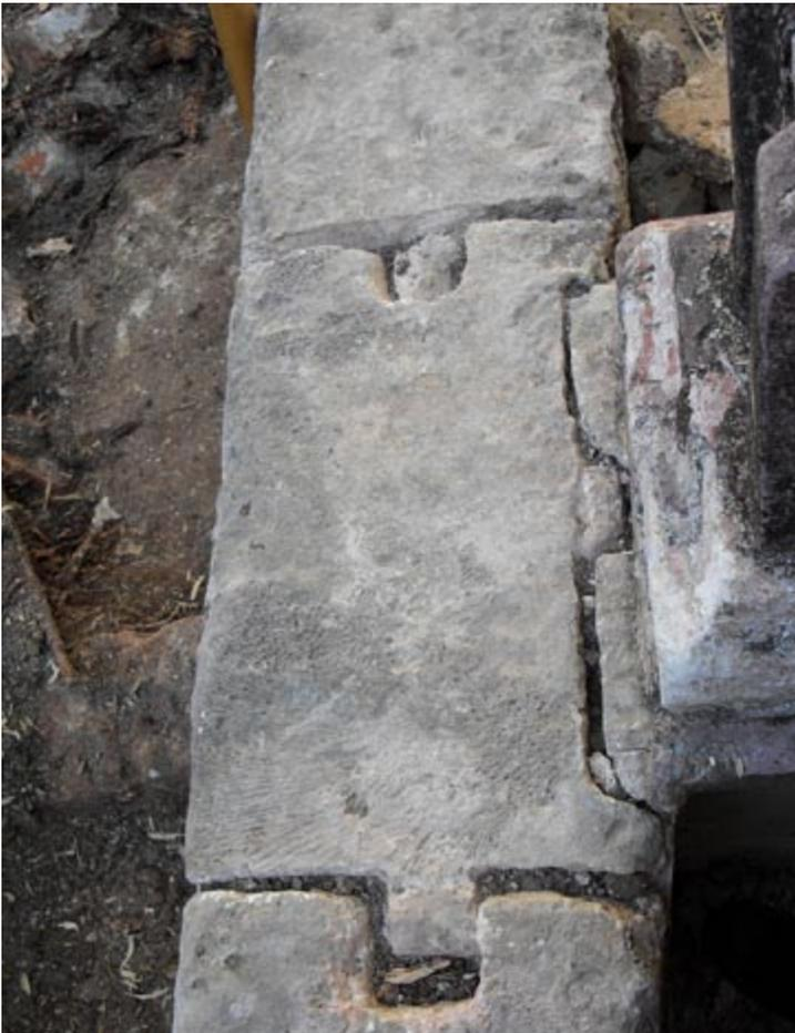
Figura 3. Detalle del sistema machihembrado para unir los elementos de la fuente.
