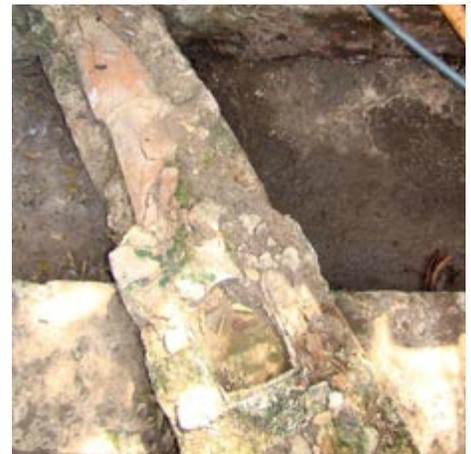
Figura 9. Conducto que une el vaso de la fuente con un baño.
