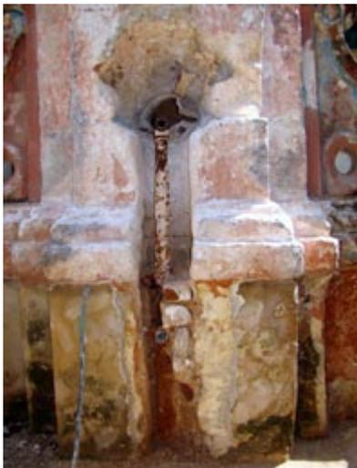
Figura 10. Tubería de hierro insertada en pilón de la fuente.
