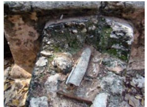
Figura 8. Tubería de plomo asociada a un conducto.
