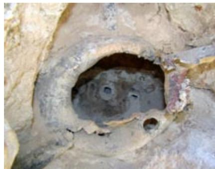
Figura 6. Esfera de plomo que colecta y reparte el agua a los surtidores..
