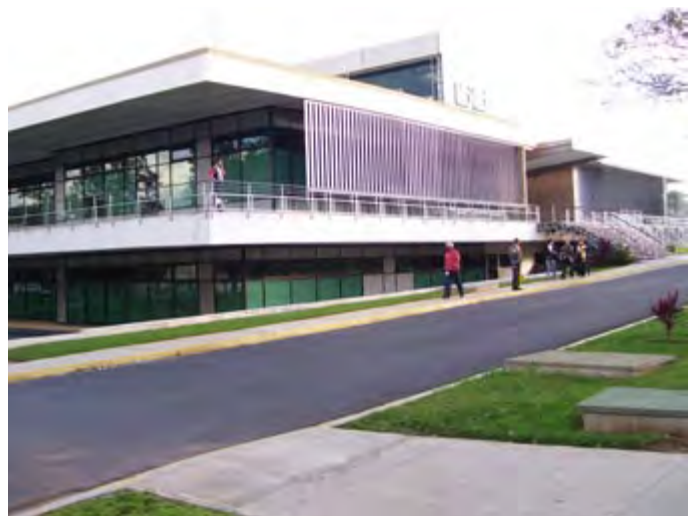
Figura 11 Edificio del nuevo centro de investigaciones Complejo de Investigaciones de tecnologías integradas (CITI) en la CUJAE, Jefe del proyecto: Rubén Bancroofft, 2010.
