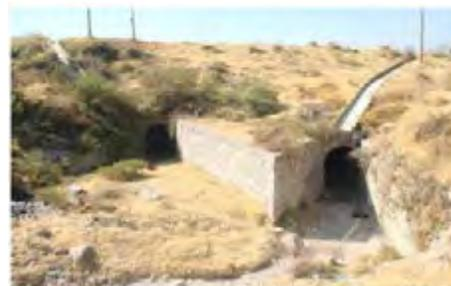
Figura 4. Ubicación de estructuras hidráulicas que pueden obstruir el paso de la corriente modificando el comportamiento hidráulico, aumentando el riesgo de inundación aguas arriba y abajo. Foto de los autores.
