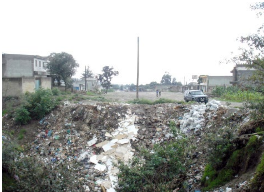
Relleno de las barrancas con basura para usar el suelo como lecho de construcción. Elaborada por los autores
