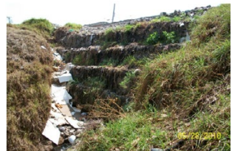
Figura 6. Se rellena el cauce de la barranca con basura, obstruyendo el escurrimiento natural del agua. Foto de los autores.
