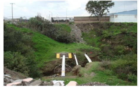
Figura 8. Ductos de PEMEX y construcción de viviendas sin respetar distancias normadas. Foto de los autores.
