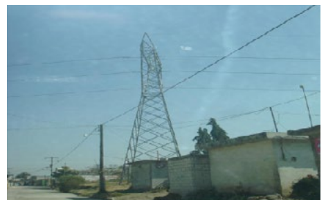
Figura 7. Líneas de alta tensión cercanas a las viviendas. Foto de los autores.
