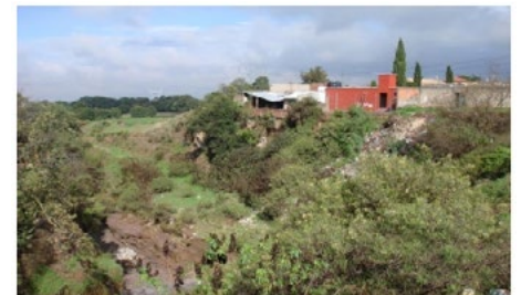
Figura 5. Viviendas construidas en el margen de la barranca sin respetar la distancia normada. Foto de los autores.
