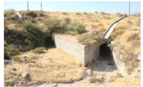
Figura 4. Ubicación de estructuras hidráulicas que pueden obstruir el paso de la corriente modificando el comportamiento hidráulico, aumentando el riesgo de inundación aguas arriba y abajo. Foto de los autores.
