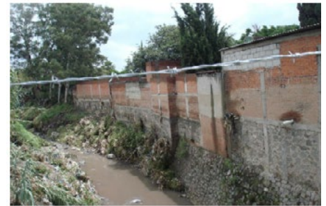
Figura 9. Escenario de repetidas inundaciones en la colonia Joaquín Colombres, por confluencia de barrancas e insuficiente espacio para el drenaje por ocuparse el cauce de la barranca con viviendas. Foto de los autores.
