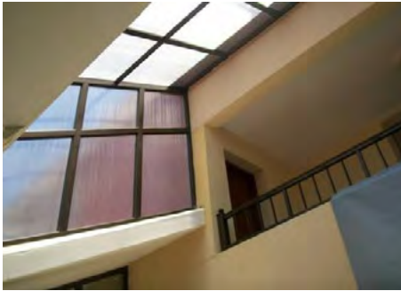
Figura 5: Superficies translúcidas en la cubierta, no protegidas. Oficinas de Cubacel en Camagüey. (Fuente: Lilybeth Torres, 2007).
