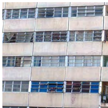
Figura 1: Fachadas con ventanas de vidrio desprotegidas del sol. Edificio de viviendas, IMS de 12 plantas. (Fuente: Lilybeth Torres, 2007).
