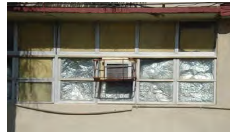
Figura 9. Ventanas de vidrio tipo marquesinas sin protección solar en una fachada del edificio de sanidad vegetal que muestran su desuso como fenestración translúcida necesaria en el interior del laboratorio.
