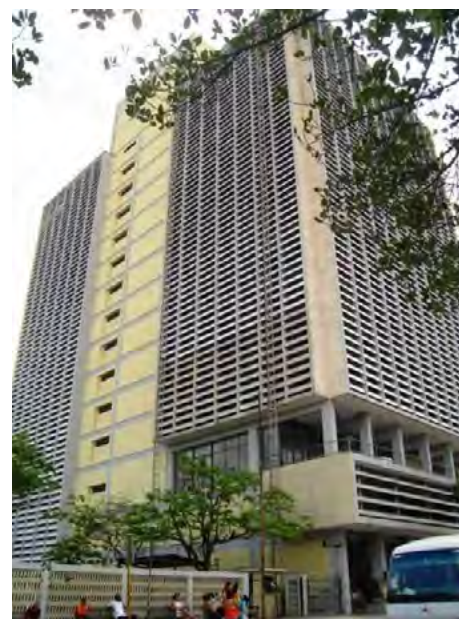
Figura 13: Fachada oeste y sur protegidas con brise-soleil. Retiro Odontológico (actual facultad de la Universidad de La Habana), Ciudad de La Habana (23° 08´ norte). (Fuente: Mairene Acosta, 2009).
