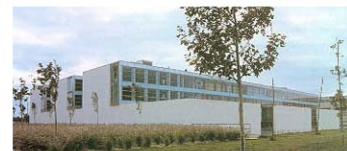
Figura 2. Escuela Politécnica IV de la Universidad de Alicante, Arq. Dolores Alonso Vera (1997-1999), donde se imparten la mayoría de las asignaturas de la carrera de arquitectura. Autores: Dolores Alonso y Alberto Mengual. Fuente: Revista VIA arquitectura , http://www.via-arquitectura.net/08/08-064.htm
