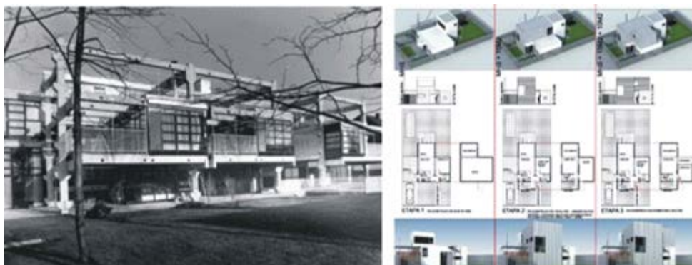
Figura 19: Vivienda crecedera dentro de una estructura soporte. Wohnanlage Genter Strasse, Otto Steidle, Alemania, 1972 ( www.afewthoughts.co.uk , febrero 2010)
