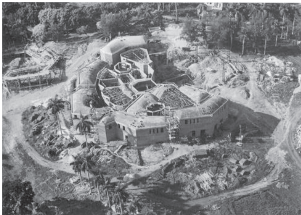
Figura 10: Escuela de Artes Dramáticas en construcción. Fotografía archivo de la Oficina del Historiador de la Ciudad.
