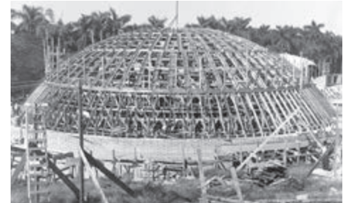
Figura 8: Escuela de Ballet en construcción. Se aprecian los encofrados para el hormigonado de nervios y anillos sobre los que se tenderán las bóvedas tabicadas. Fotografía archivo Vittorio Garatti.
