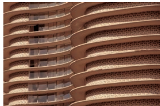
Figura 9: Oscar Niemeyer, Edificio Liberdade, Belo Horizonte, Minas Gerais, 1954–60 (luego llamado Edificio Niemeyer): detalle de la fachada con brise-soleils horizontales que se extienden sobre las paredes sólidas, revestidas de azulejos de Athos Bulcão. Fotografía de la autora.
