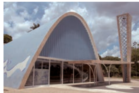
Figura 6: Oscar Niemeyer, Igreja de San Francisco de Asís, Pampulha, Belo Horizonte, Minas Gerais, 1940-42. Fotografía de la autora.
