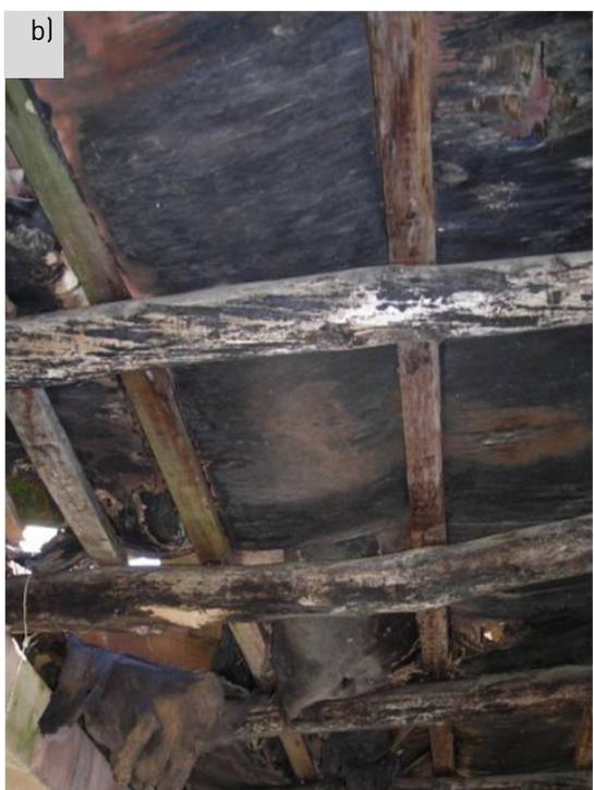
Figuras 10: Deterioros encontrados en las viviendas de Uige (cubiertas).
