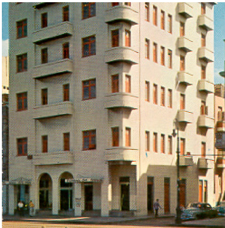
Figura 10: Hotel Ocean funcionando como hotel. Fuente: Archivo fotográfico. Plan Maestro Oficina del Historiador de la Ciudad.
