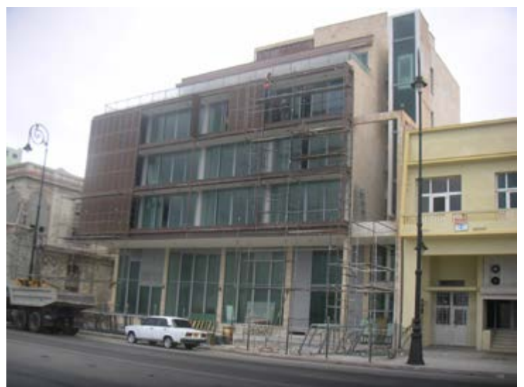
Figura 21: Hotel Terral. Fuente: Autores.
