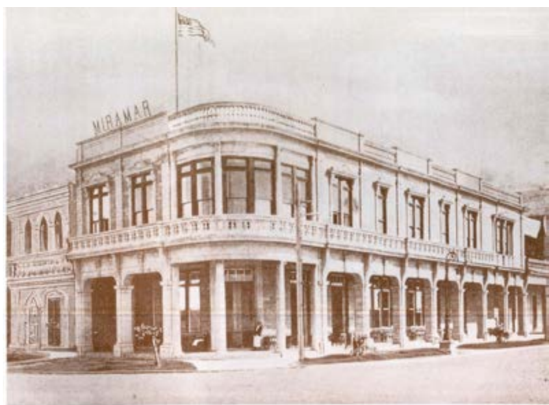
Figura 3: Hotel Miramar. Fuente: Archivo fotográfico. Plan Maestro Oficina del Historiador de la Ciudad.
