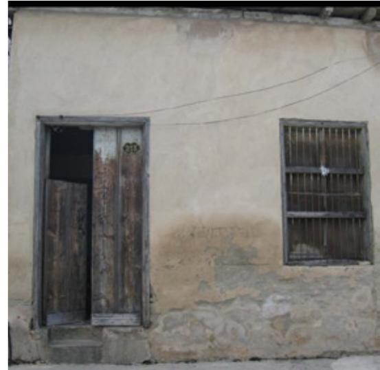
Figuras 1, 2 y 3. Efectos de la humedad capilar y el deterioro en viviendas coloniales. Fuente: autores.
