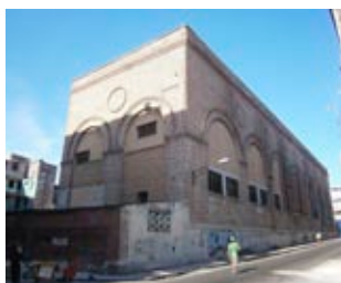
Figura 2: Antigua planta eléctrica de Colón.
