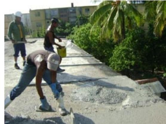
Figura 3. Proceso de hormigonado de la carpeta.
