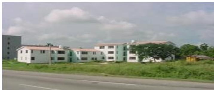
Figura 13: Edificio con entresijo y cubierta de ferrocemento, Cujae, La Habana.
