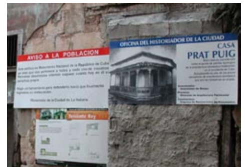
Figura 9: Convocatoria pública del Historiador de la ciudad dirigida a los vecinos para apoyar en el cuidado del inmueble sito en la calle Teniente Rey No. 159-161, con el fin de lograr detener el saqueo de sus componentes cuando este se encontraba en etapa de desuso, antes de su restauración en 2002.
