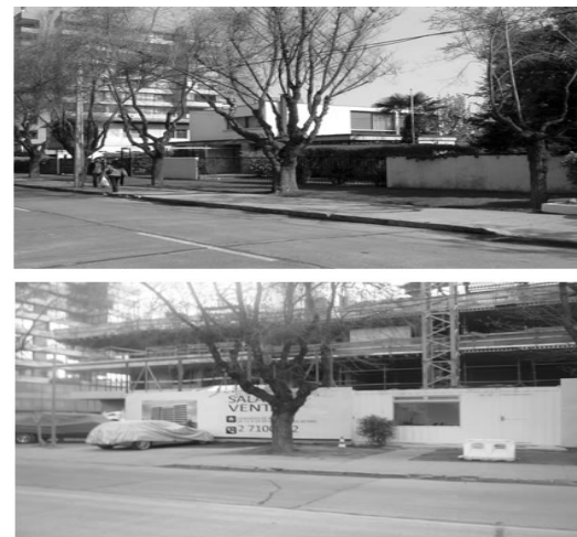
Figura 1: Casa Ravera hacia el año 2007 y edificio de departamentos, de inmobiliaria Isidora 23, en construcción, año 2013, en terrenos en que se ubicaba la casa Ravera. Fuente: Archivo fotográfico del autor.
