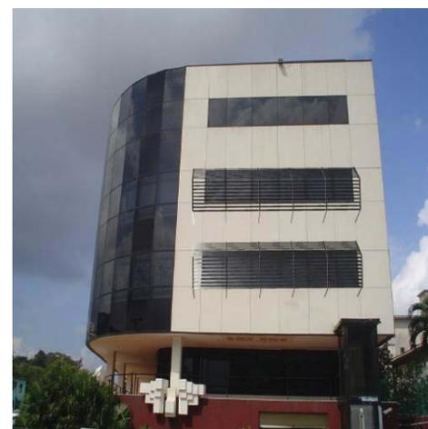
Figura 7: Elemento de protección solar seleccionado.
