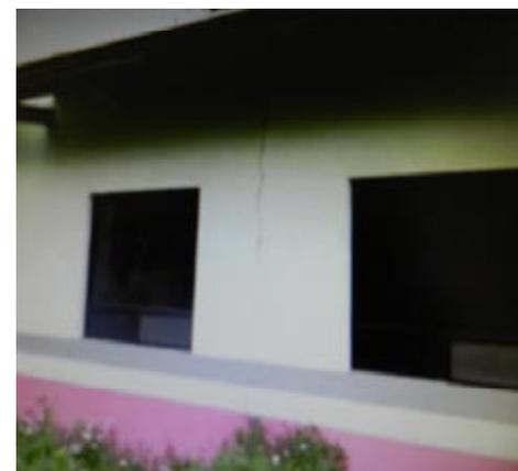
Figura 8. Fractura en muro lateral de la guardería. Fuente. Periódico *El Sol de Puebla*.
