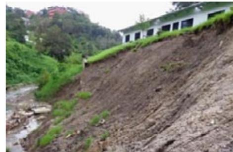
Figura 5. Desplome del muro de contención y deslave del talud. Fuente. Periódico *El Sol de Puebla*.
