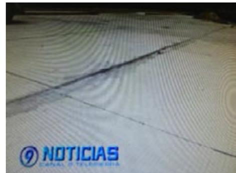
Figura 6. Hundimiento y fractura de losa del estacionamiento. Periódico *El Sol de Puebla*.
