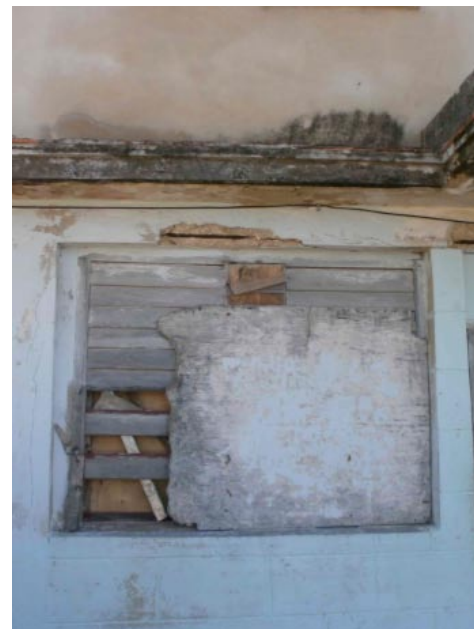
Figura 17. Lesión Pérdida de la capa protectora. Ave. 1ra No. 30811. Fuente: Autores.
