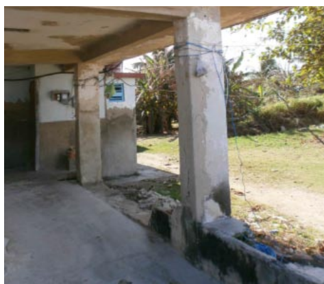
Figura 15. Lesión Humedad. Ave. 1ra No. 30402. Fuente: Autores.
