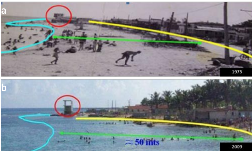
Figura 1a. Playa La Puntilla. Retroceso de la línea de Costa de aproximadamente 55 m en los últimos 39 años figura 1b. Derrumbes parciales. Fuente: Revista Ciencias de la Tierra y el Espacio (2012).
