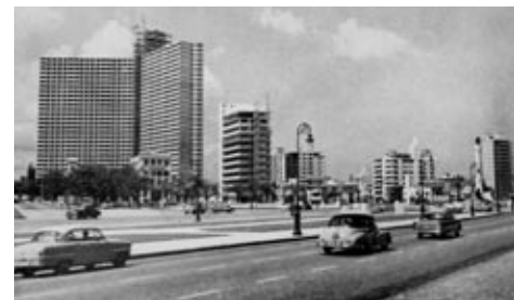
Figura 15: Vista de un rascacielos en construcción, en la entrada de El Vedado, La Habana, años 1950. En primer plano, en construcción, el Edificio FOCSA, de 121 metros, el tercer edificio de hormigón armado más alto del mundo en el momento de su terminación y el segundo edificio más alto de La Habana. Fotografía: Álbum de Cuba (La Habana: Universidad de La Habana, Facultad de Arquitectura, sin fecha)
