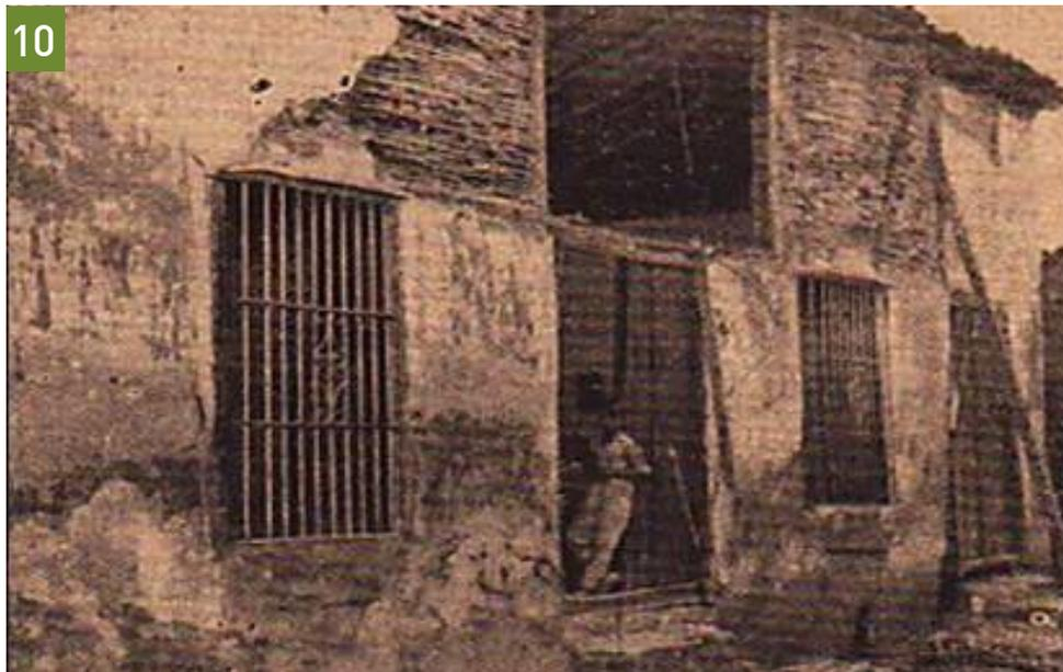
Figuras 10 y 11: Las construcciones del período de la colonia soportaron mejor los efectos del sismo, se destaca que aunque los muros de cuje perdieron el revestimiento y sufrieron algunos desprendimientos, no colapsaron.
