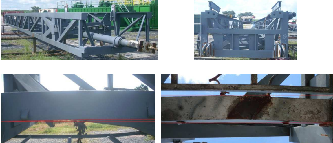
Figura 1. Vistas de la sección superior e inferior de la torre (arriba) así como lateral e inferior del elemento deformado (debajo)
