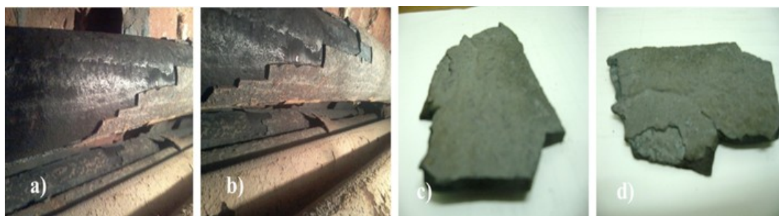
Figura 1. Películas adheridas a la superficie de los tubos en la zona de convección del horno
