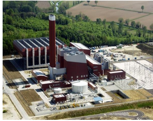
Figura 2. Planta de 600 MW que usa ACC como estrategia para proteger el agua destinada a la agricultura (China)
