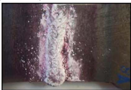
Fig. 1. Grieta longitudinal en una unión soldada a tope de acero AISI 1015, detectada mediante líquidos penetrantes
