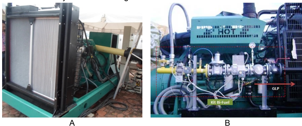
Fig. 2. Motogenerador Cummins DFEH (a) e instalación del Kit Bifuel antes del ingreso de aire al turbocargador (b)
