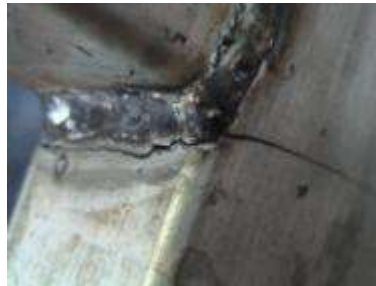
Fig. 1. Localización de la grieta en el miembro estructural de un autobús
