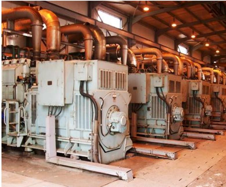
**Fig. 3.** Generadores HSR7 637-8P de una central eléctrica de fuel oil, de La Habana. Fuente: autores
