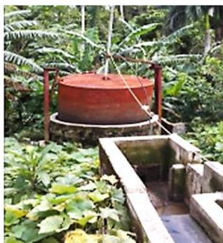
Fig. 1. Biodigestor de cúpula móvil instalado en el establo porcino. Fuente: autores
