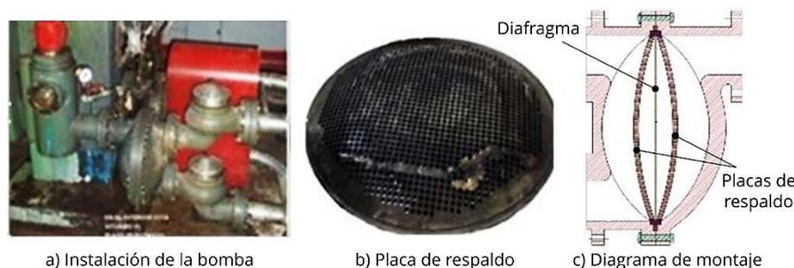
**Fig. 1.** Instalación de la bomba, placa y diagrama de montaje. Fuente: autores
