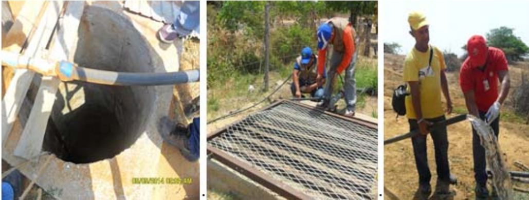
Figura 2. Imágenes de algunas de las fuentes de abasto. Izq. Pozo artesanal; Centro: Cisterna; Der. Tubería de aducción.
