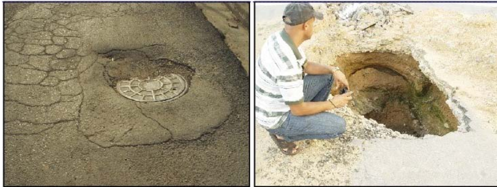
Figura 7. Hundimientos y colapsos de carreteras debido al fenómeno de erosión subterránea, ciudad de Pinar del Río, Cuba Occidental.
