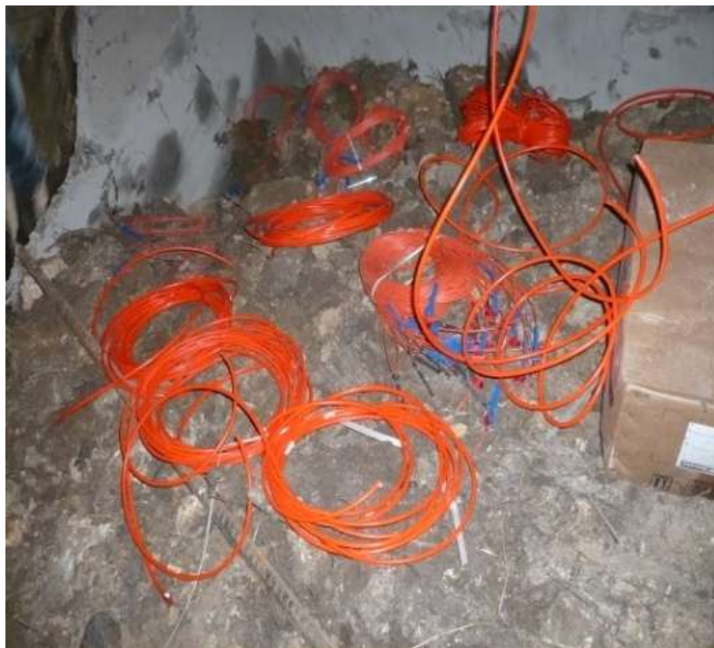
Figura 4. Cordón detonante de alto gramaje utilizado en la voladura de contorno por recorte en el túnel de Buenaventura (Trasvase Este-Oeste).
