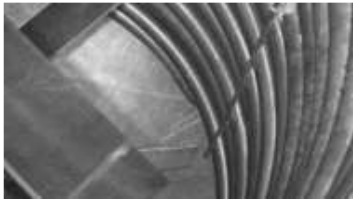
Figura 2. Zona cercana a la falla sin soportes.
