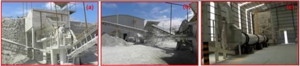
Figura 5. Planta de procesamiento de yeso. (a) Tolva y molino; (b) Bandas transportadoras y acopio; (c) Horno rotatorio.
