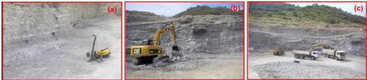
Figura 4. Proceso de explotación de yeso en la cantera. (a) Perforación y detonación con explosivos; (b) Acopio con retroexcavadora hidráulica giratoria; (c) Cargamento y transporte.
