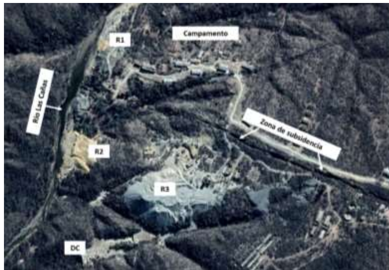
Figura 1. Imagen satelital de la antigua mina Los Córdores. Referencia: diferentes relaves (R), dique de cola (DC), río Las Cañas, zona de subsidencia y campamento.
