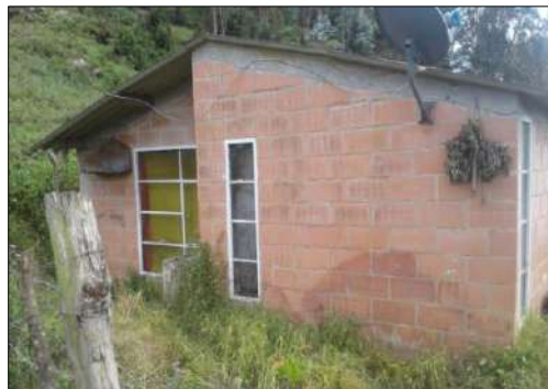
Figura 2. Vivienda típica cercana a los sitios donde se realizan las voladuras.
