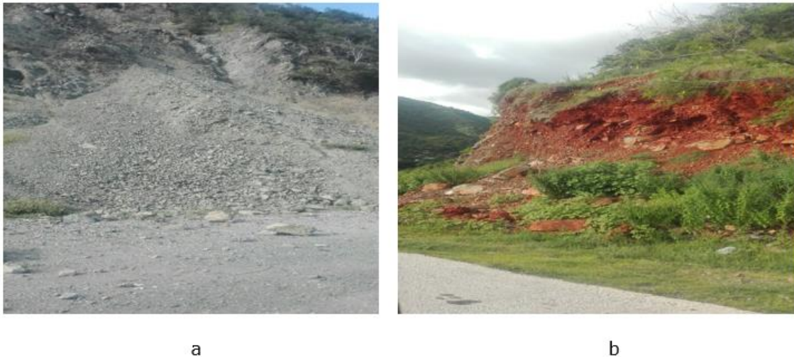
Figura 1. Deslizamientos en el sector de estudio. a). Deslizamiento localidad El Macho; b). Desprendimiento localidad La Bruja.
