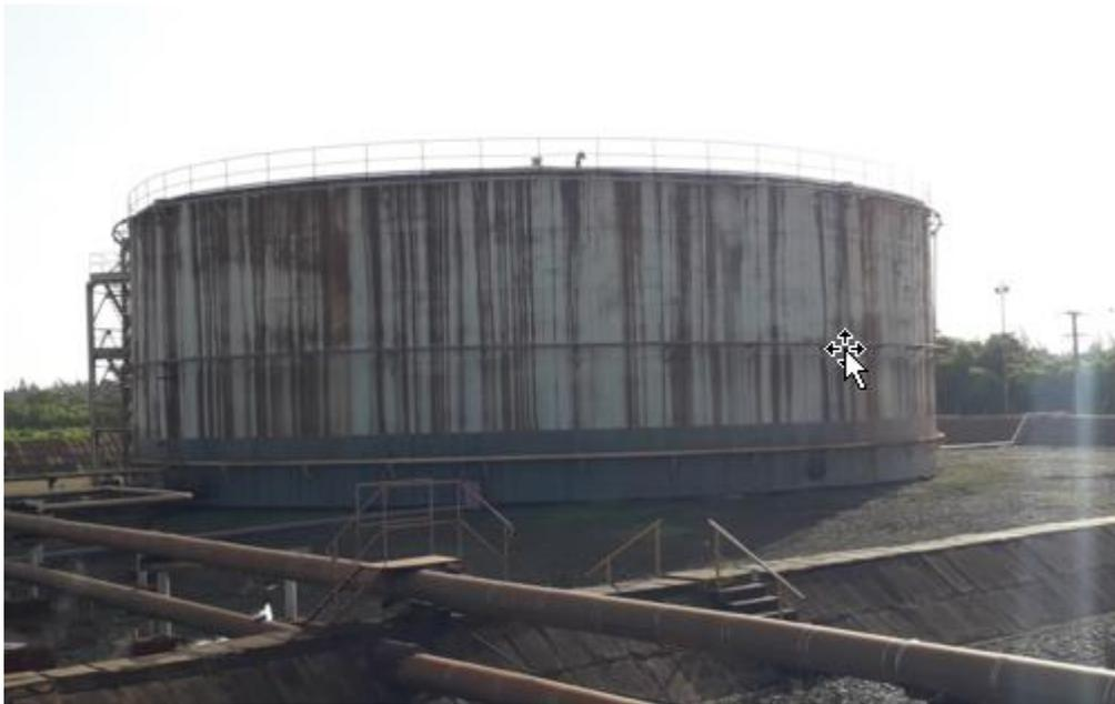
Figura 1. Tanque de combustible del puerto de Moa. Al cabo de varios años de uso se limpian extrayendo los lodos petrolizados que se acumulan en el fondo y se convierten en pasivos ambientales.
