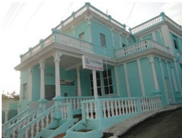
Figura 9. Policlínico Francisco del Sol después de la reinauguración.
