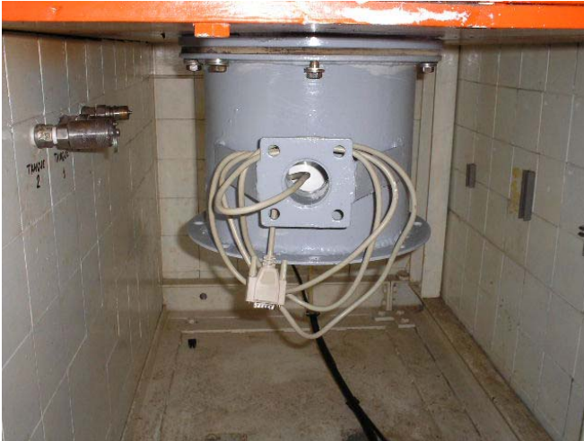
Figura 4. Soporte del pozo de calibración.
