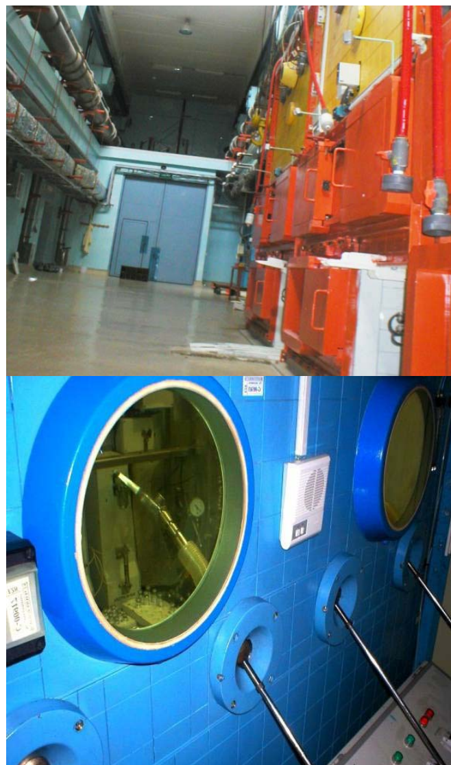
Figura 1. Corredor caliente y acceso posterior de la celda zona II, zona de trabajo (I) y de operadores (III).
