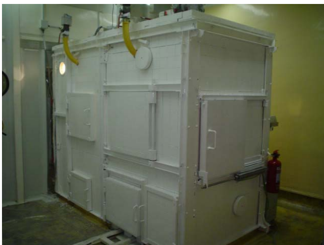
Figura 12. Vista actual de la instalación de celdas con las nuevas puertas de acceso.
