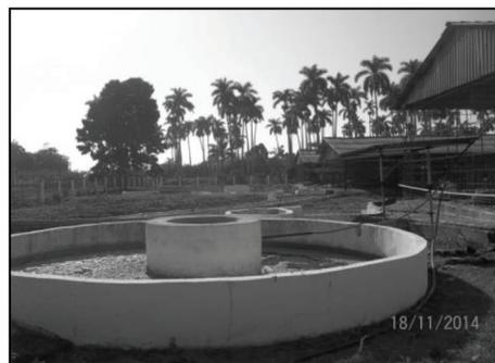
Foto 2. Biodigestor de 50 m<sup>3</sup>.
