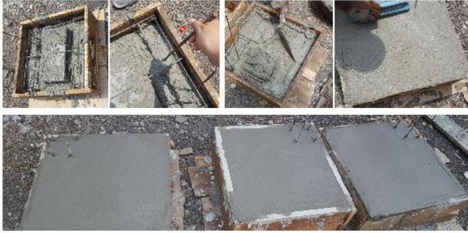
Figura 11. Fundición y acabado de segmentos de losa.
