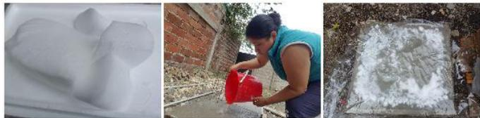
Figura 33. Segmentos de hormigón al segundo día tras fundición.
