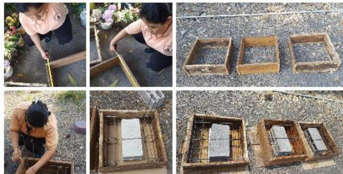
Figura 4. Preparación de moldes para segmentos de losas.
