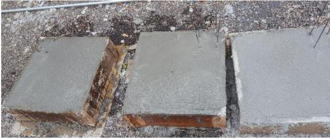
Figura 31. Segmentos de losa humedecidos.
