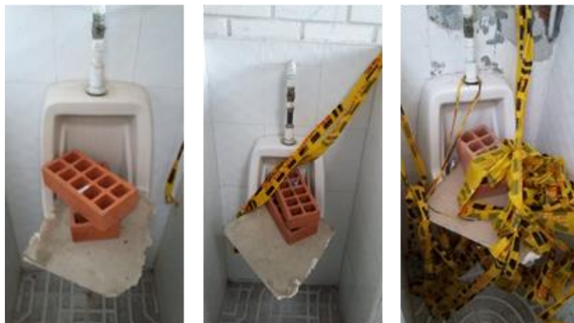
Figura 3. Baterías sanitarias de una edificación escolar en Manizales.
