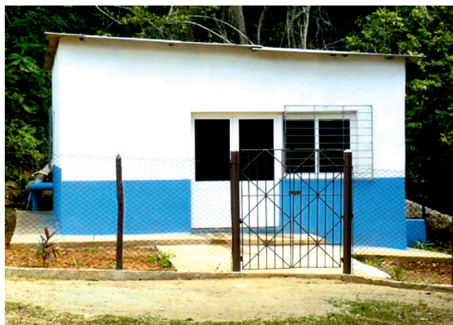
FIGURA 3. Hidroeléctrica La Victoria.
