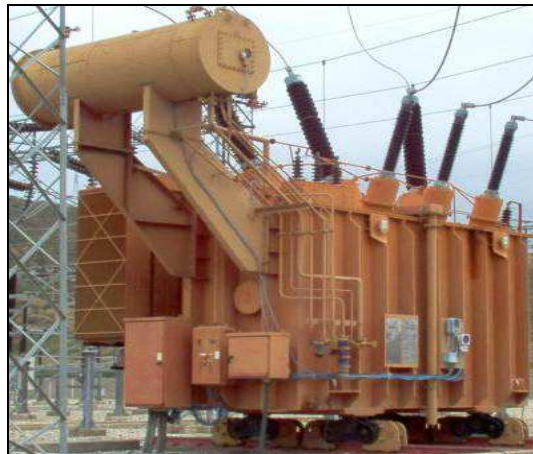
Fig. 1. Autotransformador No.2 de la Subestación Barquisimeto, Venezuela.
