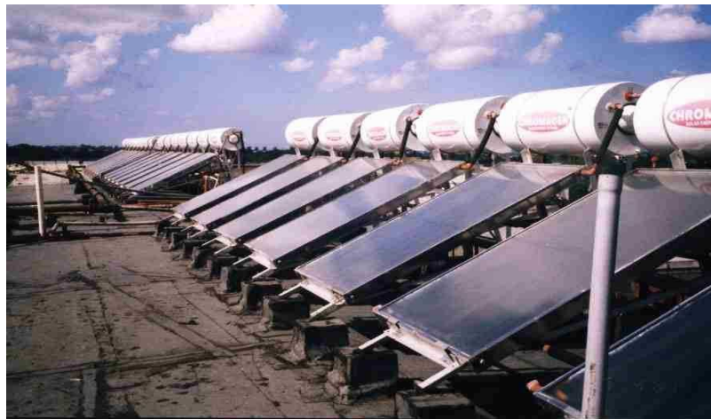
Foto 1. Vista general de la Instalación Solar con 3 Baterías y 41.8 m 2 de área total de captación.
